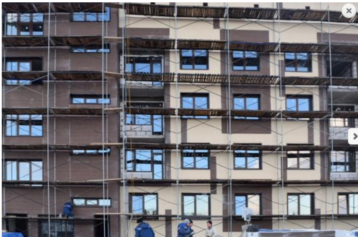
Фото 3. Строящийся жилой комплекс
