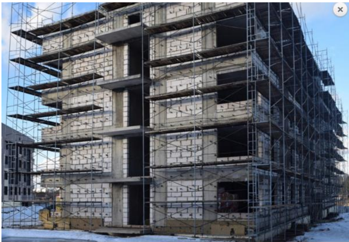
Фото 1. Строящийся жилой комплекс
