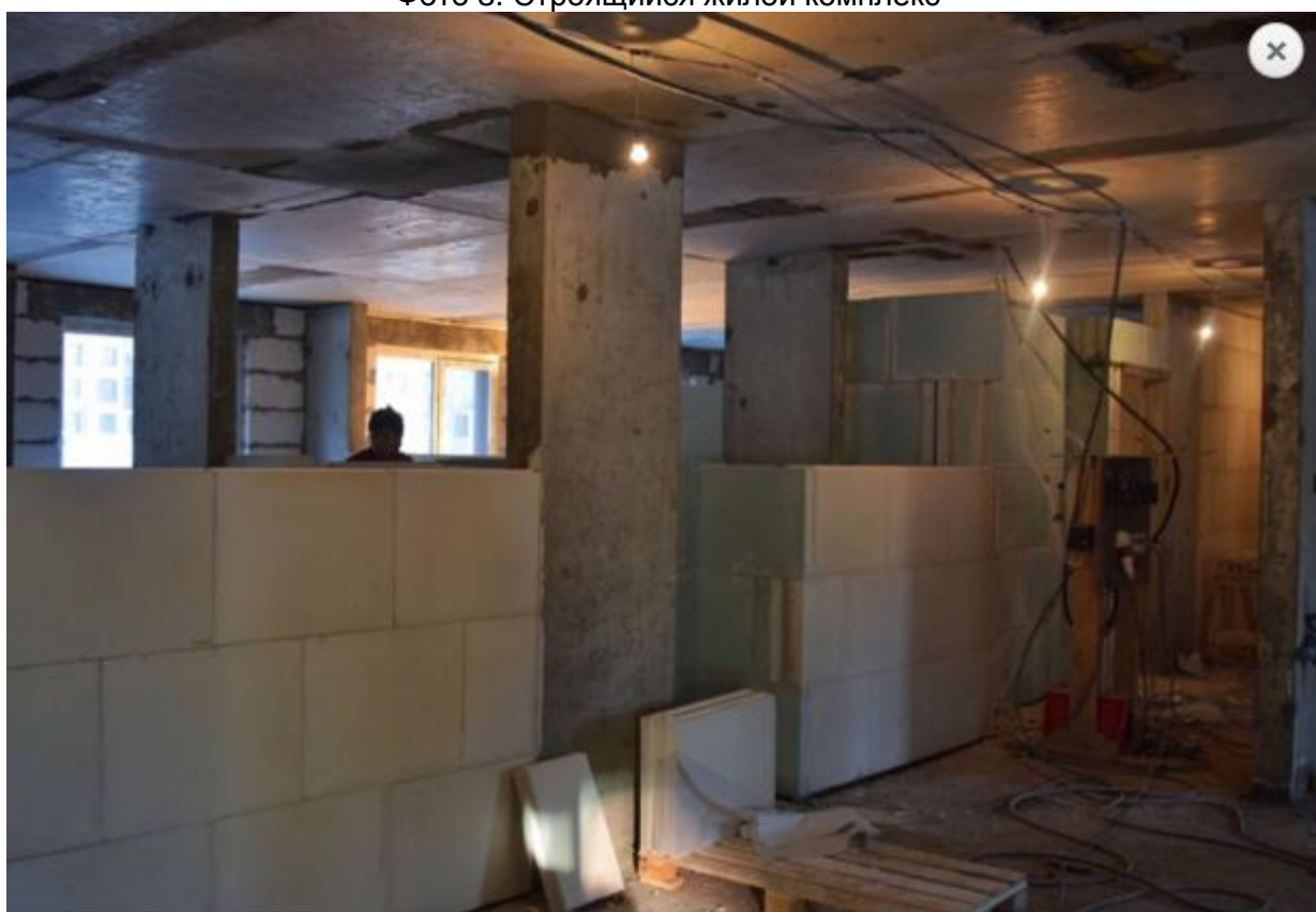
Фото 4. Строящийся жилой комплекс
