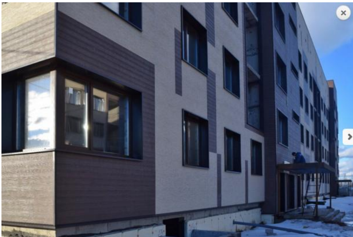
Фото 5. Строящийся жилой комплекс
