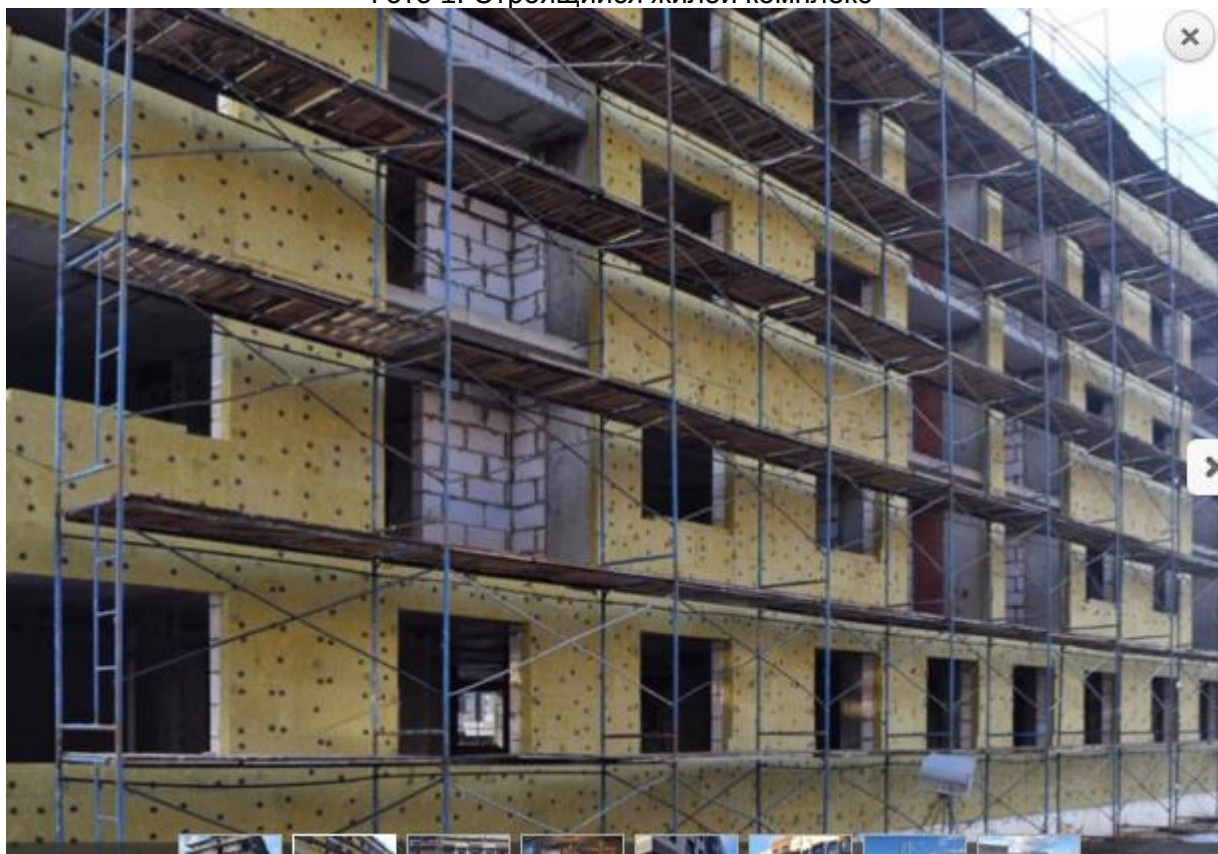
Фото 2. Строящийся жилой комплекс
